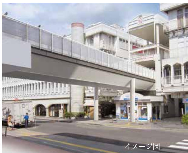
新設する歩道橋
