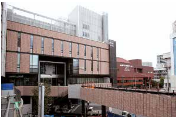
○商業施設 I 期の 2 階正面玄関と歩行者デッキ
